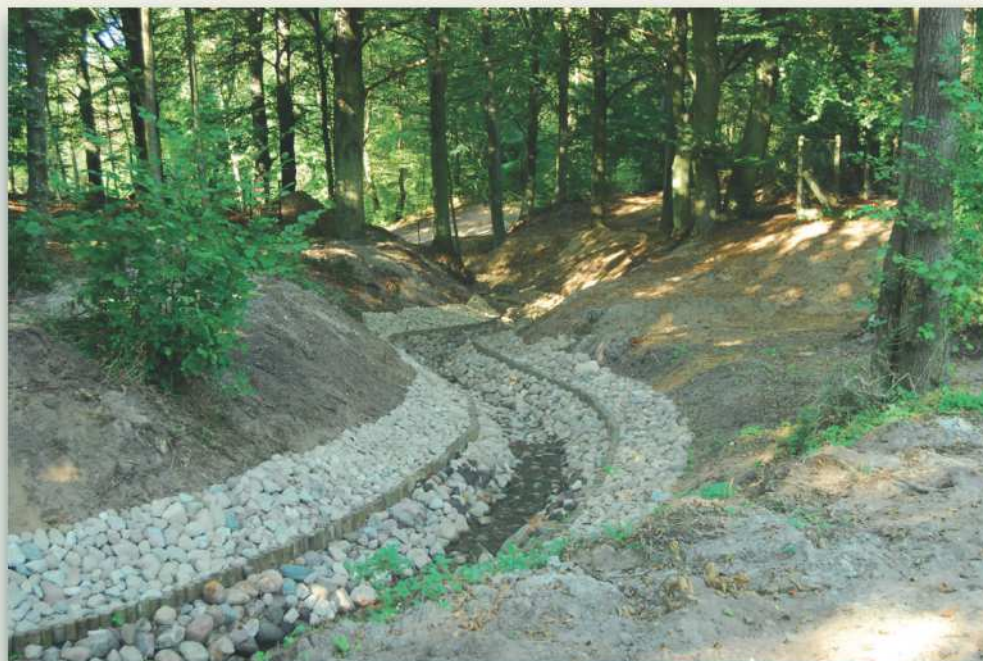
13.1, 13.2. Przeławka na Redze w Rejowicach w trakcie i po zakończeniu budowy Fish pass on the Rega in Rejowice under construction and after opening
