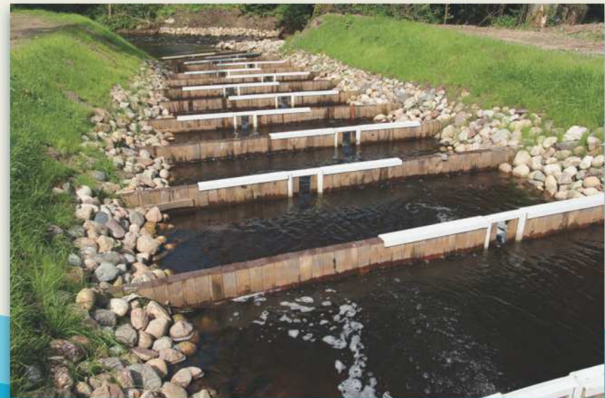
9.1. Bystrze kaskadowo – ryglowe na dopływie Regi w Suliszewicach Cascade and transom rapids on the tributary of the Rega in Suliszewice
