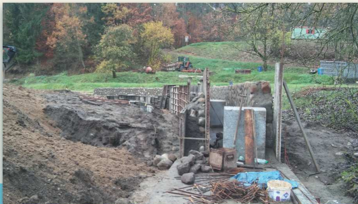
17.1. Przeławka w trakcie budowy Fish ladder under construction
