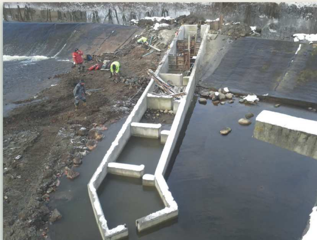
14.1 Przepławka w trakcie budowy Fish ladder under construction
