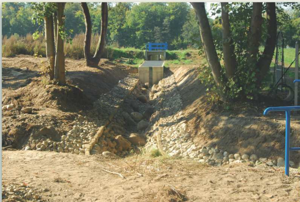
12.1, 12.2. Przepławka na Redze w Rejowicach w trakcie i po zakończeniu budowy Fish pass on the Rega in Rejowice under construction and after opening
