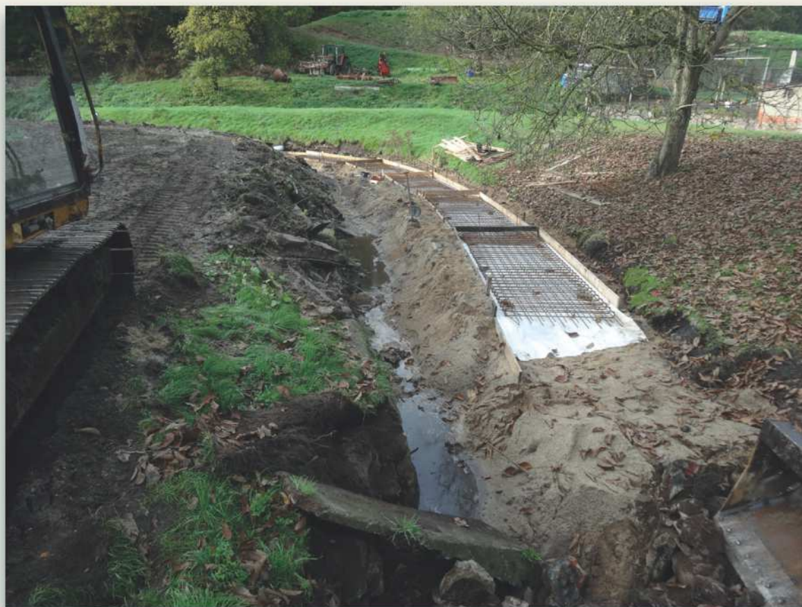
16.1. Przepławka w trakcie budowy Fish ladder under construction
