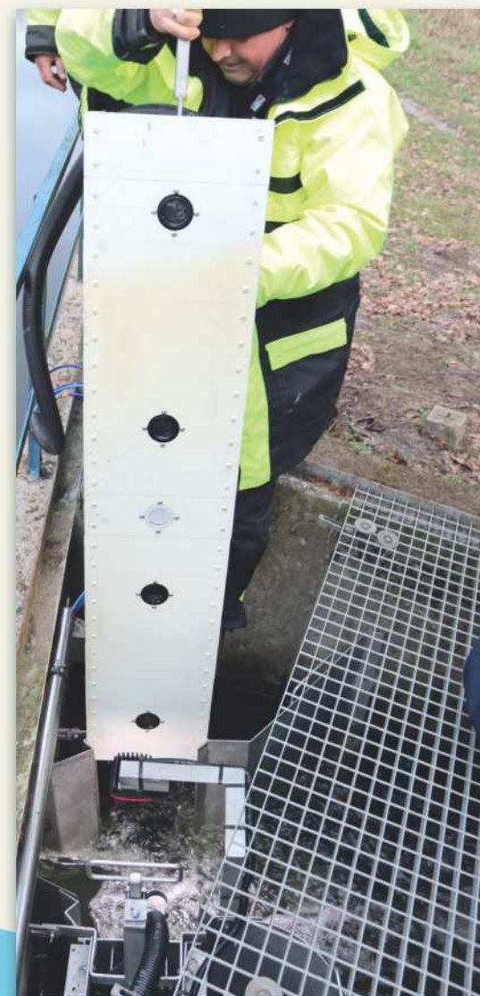
20.1, 20.2. Montaż urządzeń (kamer wizyjnych oraz echosondy) do monitoringu ryb w przepławkach. Na zdjęciu po lewej widoczne są cztery obiektywy kamer umieszczone na jednej płycie. Installation of devices (video cameras and echo sounders) for monitoring fish in fish passes. The photo on the left shows four camera lenses placed on one plate.
