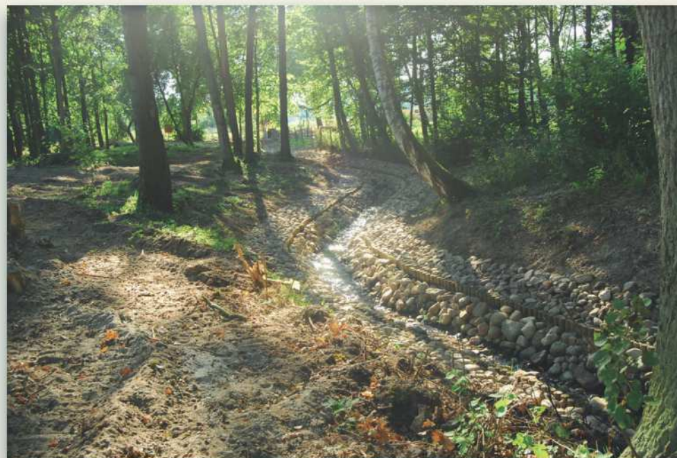
13.1, 13.2. Przeławka na Redze w Rejowicach w trakcie i po zakończeniu budowy Fish pass on the Rega in Rejowice under construction and after opening
