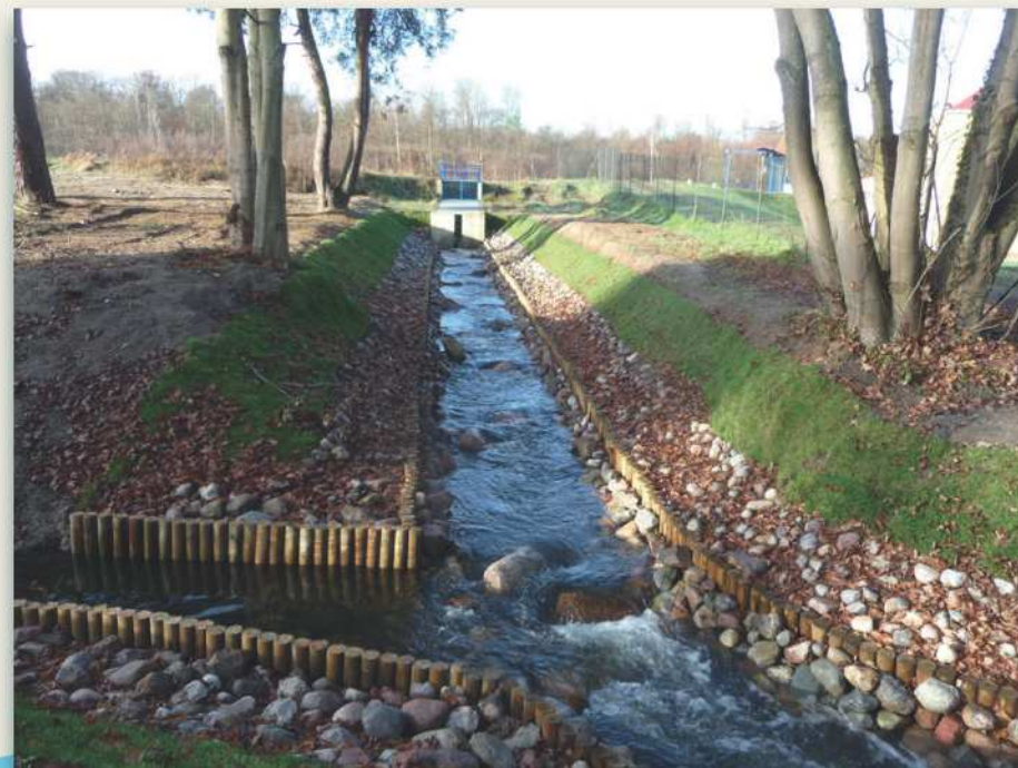
12.1, 12.2. Przepławka na Redze w Rejowicach w trakcie i po zakończeniu budowy Fish pass on the Rega in Rejowice under construction and after opening
